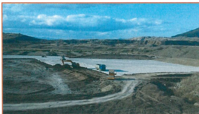
Изграждане на регионално депо за неопасни отпадъци в регион Ямбол
